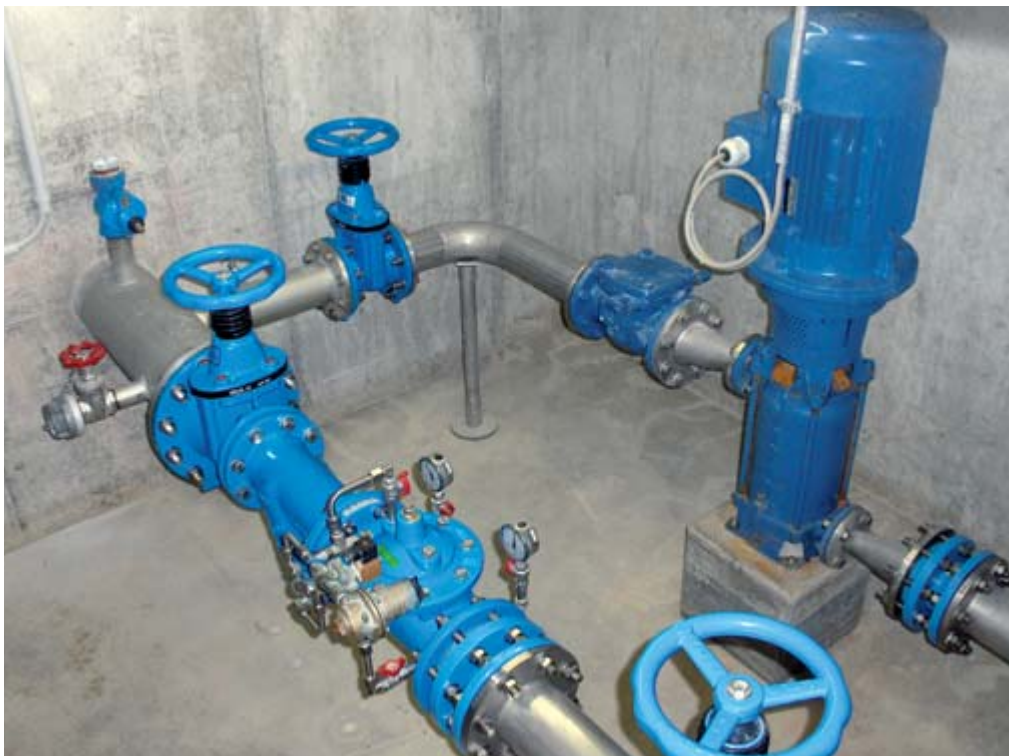
Rückwärtslaufende Kreiselpumpe als Turbine.
